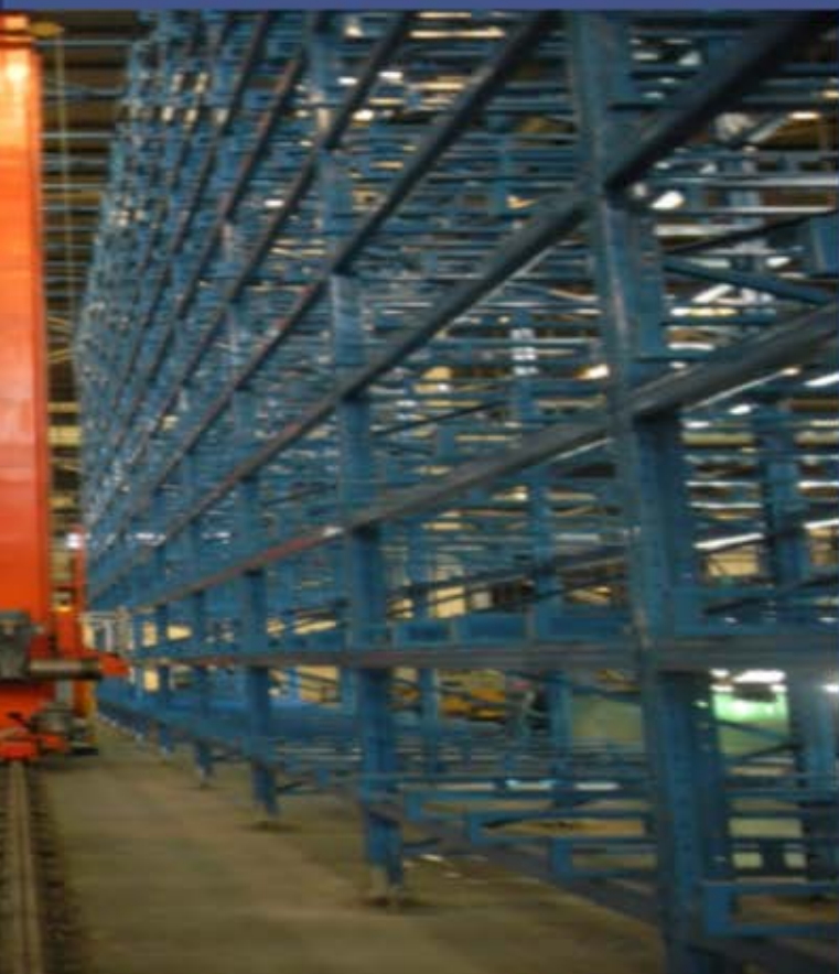
TRANSELEVADOR DE UNA COLUMNA, ALMACÉN AUTOMATIZADO.
